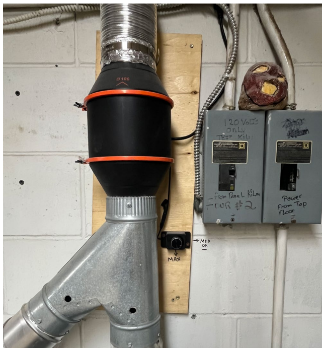
Nouveaux moteurs dans la salle des fours, automne 2024.
