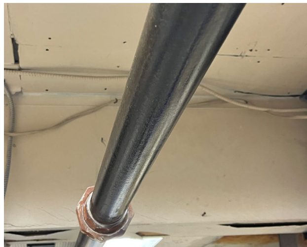
Tuyau d'eau, après le sablage.
